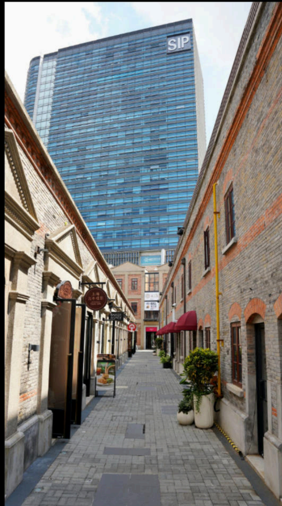
Viela de shikumen restaurada, com a torre nova ao fundo
